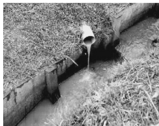
写真2 排水口からの濁水の流出(筆者写す)
