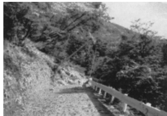
同地震による地盤崩壊
