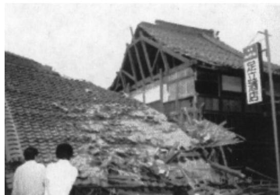
鳥取県西部地震による木造建物の被害
