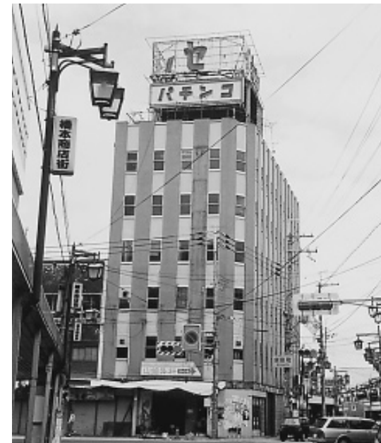
写真1 イセヤビルの外観
