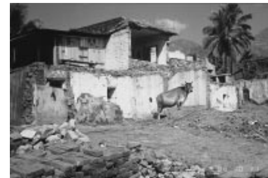
ネパールの地震被害
