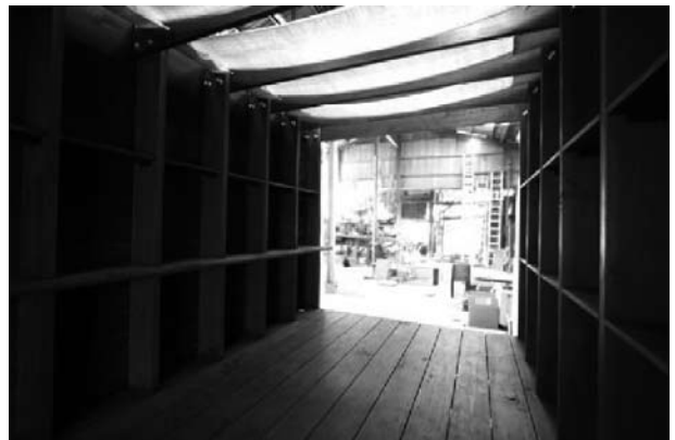
写真8： 同内観 薄板ラーメン構造にて 短辺方向を全面開口
