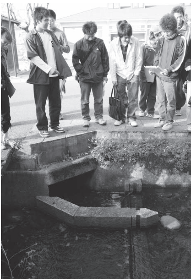
写真1. 現地で見つけた水路内の設備について議論する (甲良町にて)
