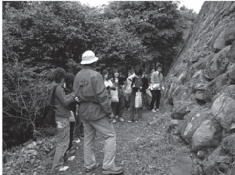
写真2 彦根城における転用材の視察
